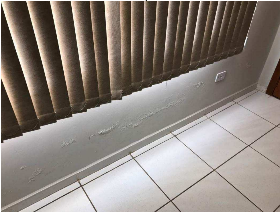
Foto 16 – Infiltração em Janela.
