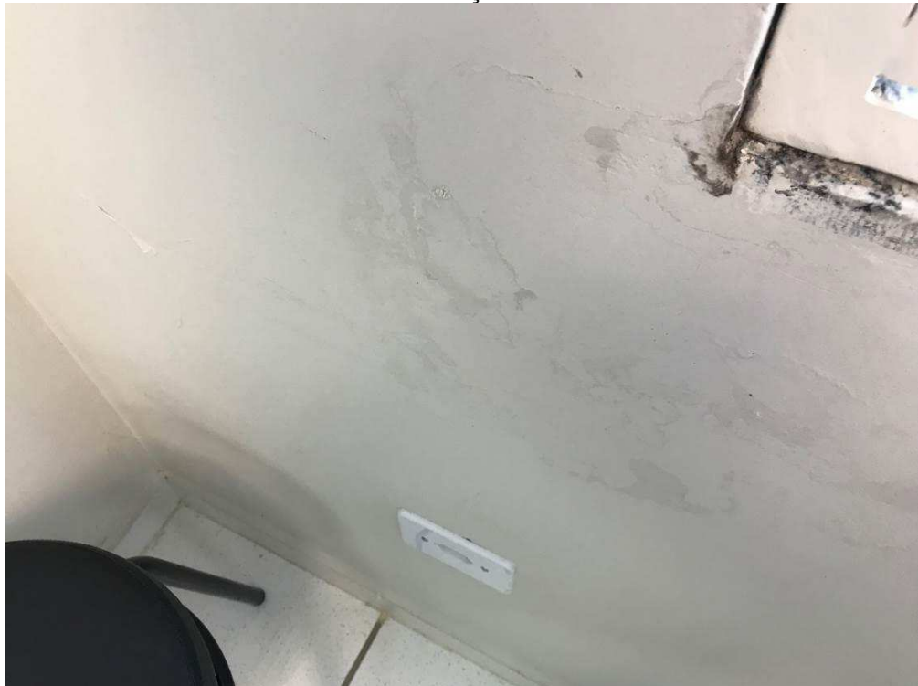
Foto 14 – Infiltração em Janela.
