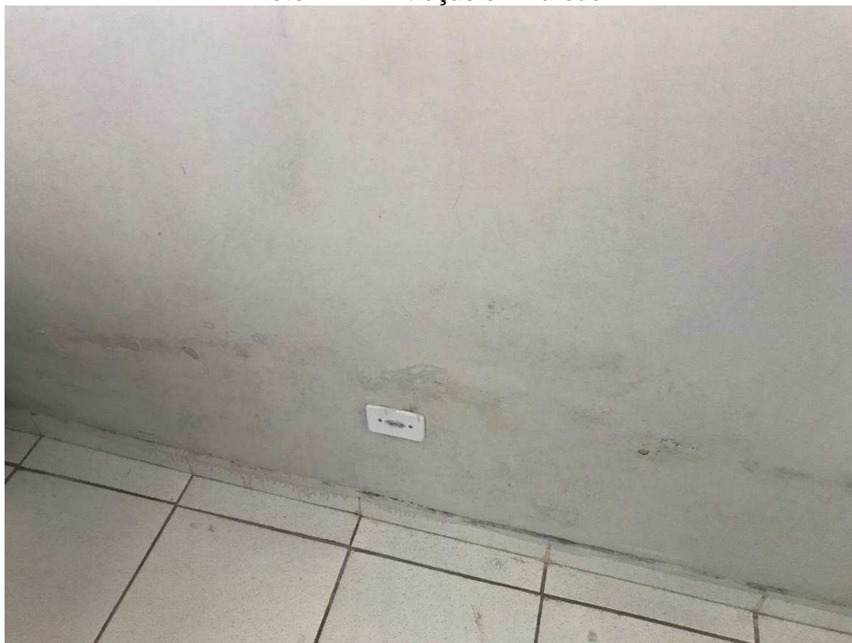
Foto 17 – Infiltração em Parede.
