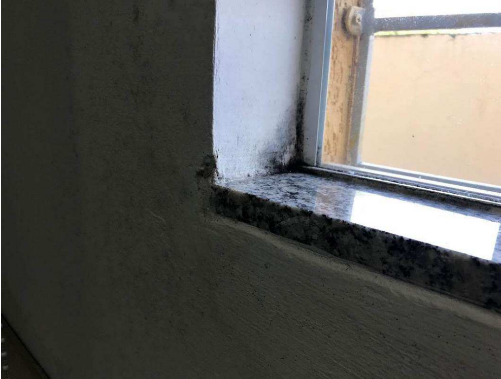
Foto 15 – Infiltração em Janela.
