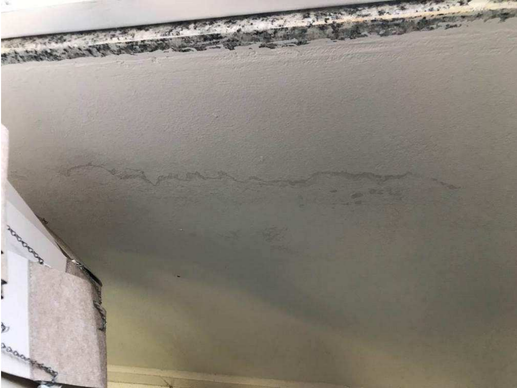
Foto 13 – Infiltração em Janela.
