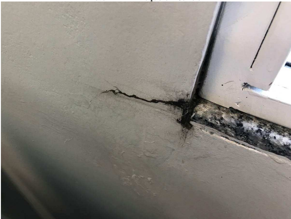
Foto 12 – Infiltração em Janela.
